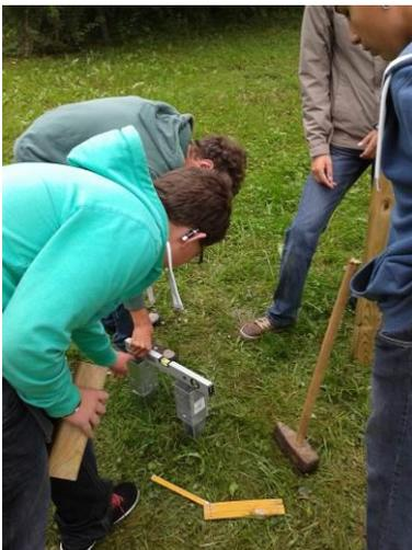
Wir haben mit der Wasserwaage geschaut, ob alle Bodenanker auf der gleichen Höhe sind. Das war gar nicht leicht, weil das Gelände am Hang liegt. Danach haben wir die Pfosten eingesetzt. Die schiefen Pfosten haben wir mit der Wasserwaage ausgerichtet. Das war auch schwierig.
