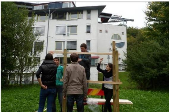
Danach haben wir die Abstände nochmals kontrolliert. Dann wurden die Schnitte für das Dach an den Pfosten angezeichnet. Zum Schluss wurde das Gestell wieder abgebaut. Die Pfosten wurden im Technikraum an der Markierung schräg abgesägt.
