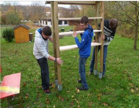
Wir haben das Gestell im Technikraum aufgestellt und das Dach drauf gelegt. Um das Gestell mit dem Dach zu verbinden, mussten wir vier Löcher bohren und dann das Dach auf die Pfosten schrauben. Das Dach wurde an jeder Schraube mit einer Dichtung abgedichtet. Danach haben wir das Wildbienenhotel in die Bodenanker gestellt und dort fest verschraubt.
